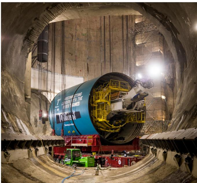
Le chantier est divisé en trois sections distinctes, avec chacune une plateforme principale à partir de laquelle quatre tunneliers creuseront le sous-sol londonien pour construire le tunnel principal.
